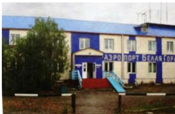
1985 г. Открытие нового аэровокзала в аэропорту Белая Гора
